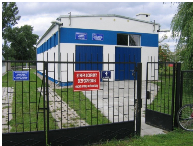
Fot. 10 Stacja uzdatniania wody w Krzycku Wielkim
