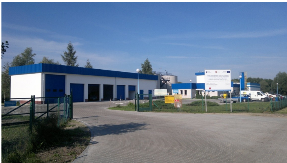
Fot.15 Oczyszczalnia ścieków w Grotnikach
