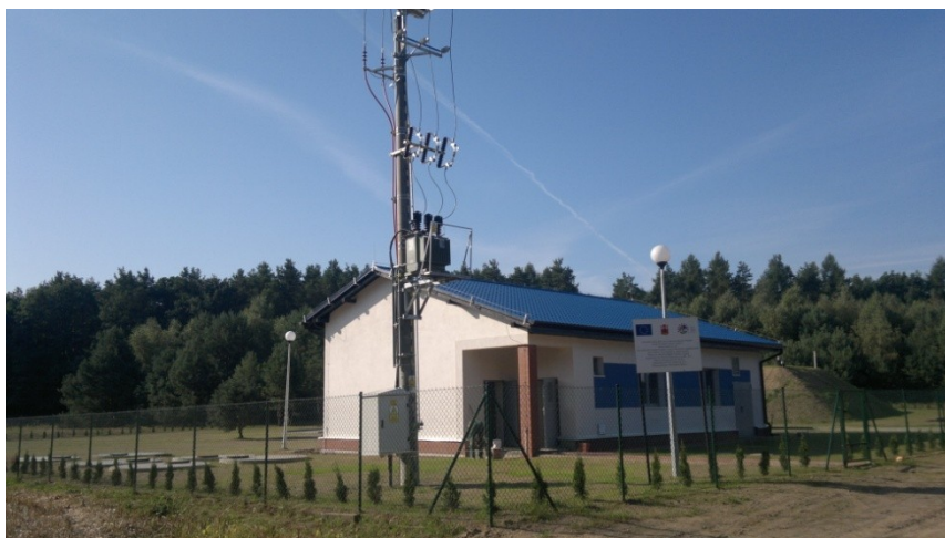
Fot. 12 Stacja uzdatniania wody w Dominicach
