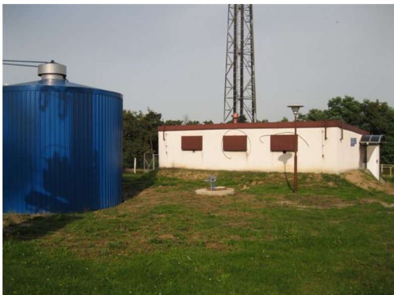
Fot.8 Stacja uzdatniania wody w Ujazdowie
