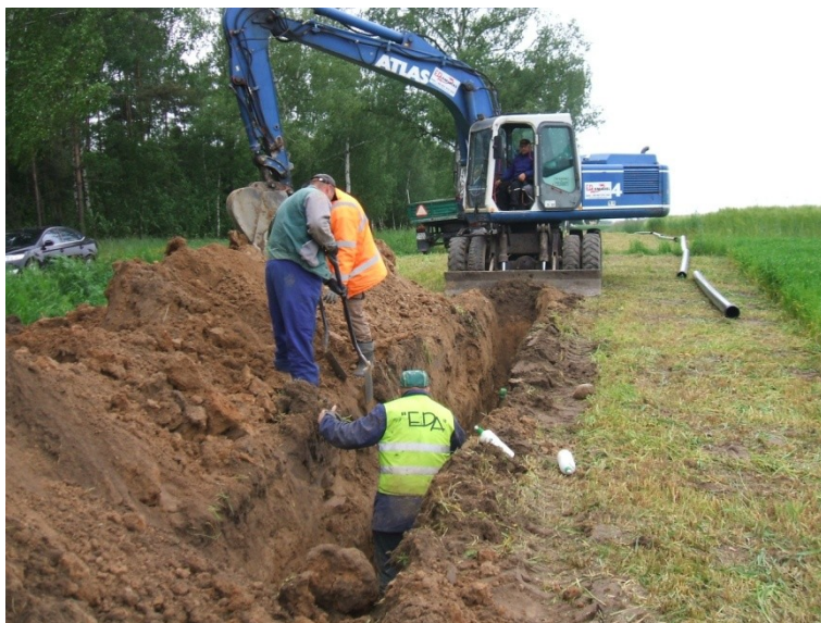
Fot. 13 Budowa sieci wodociągowej Boguszyn - Bukówiec Górny
