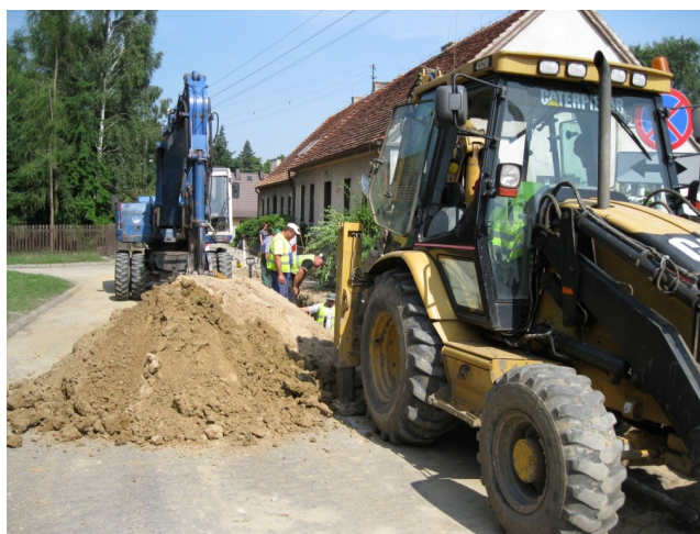
Fot. 14. Budowa sieci kanalizacji sanitarnej we Włoszakowicach 2010r.
