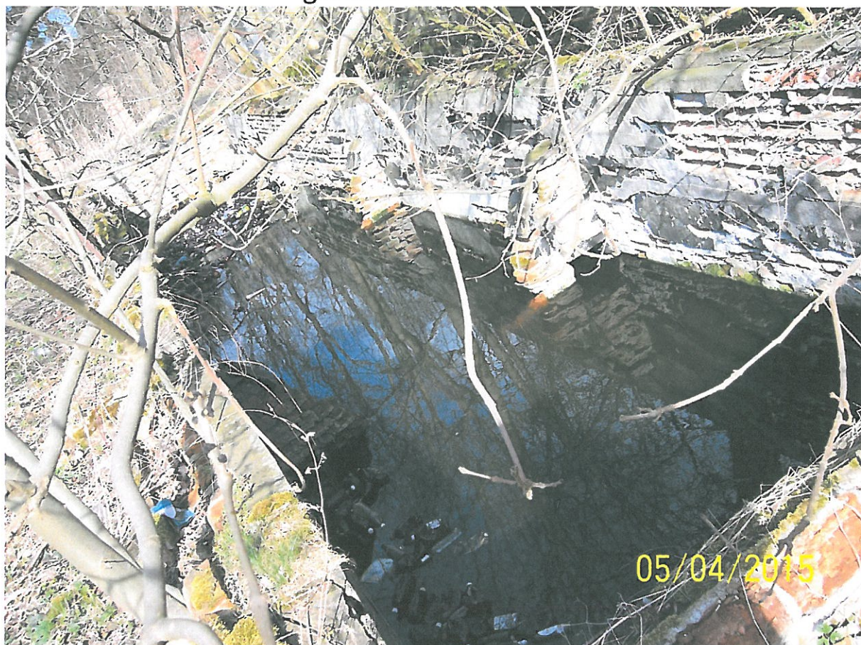
Zbiornik wykorzystywany w procesie produkcyjnym w nieczynnej gorzelni w Zbarzewie
