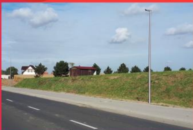
Oświetlenie uliczne na odcinku ścieżki rowerowej w Bukówcu Górnym
