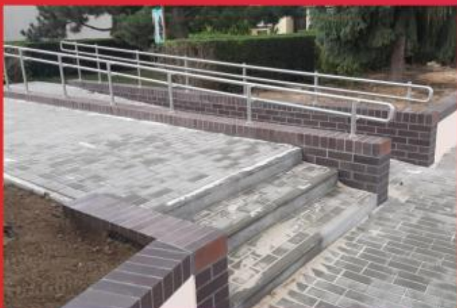
Zagospodarowanie terenu przy szkole w Krzycku Wielkim (zatoka autobusowa)
