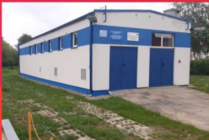
Krzycko Wielkie, remont elewacji muru fundamentowego stacji uzdatniania wody
