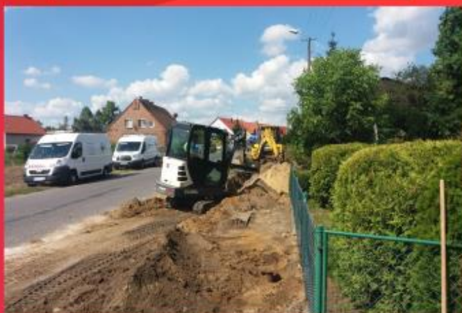
Krzycko Wielkie, wymiana przyłączy wodociągowych
