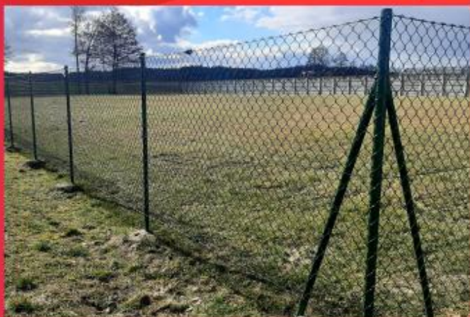
Jezierzyce Kościelne, modernizacja boiska poprzez m.in. montaż płotu
