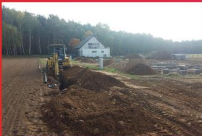
Włoszakowice, budowa sieci wodociągowej
