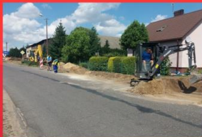
Krzycko Wielkie, wymiana przyłączy wodociągowych
