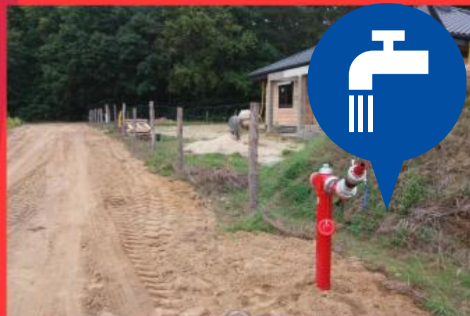
Jezierzycie Kościelne, budowa sieci wodociągowej
