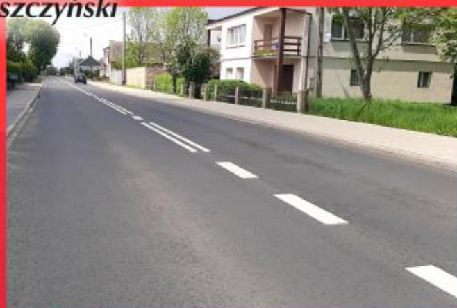
Przebudowana droga powiatowa na trasie Gołanice - Jezierzycze Kościelne
