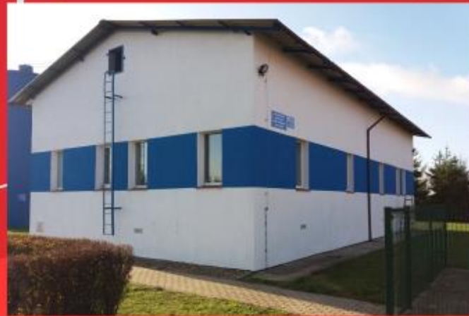
Bukowiec Górny, remont elewacji stacji uzdatniania wody
