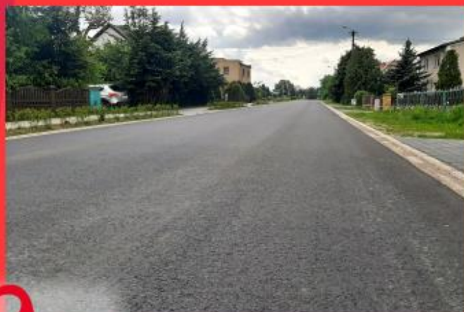
Przebudowana droga powiatowa w Krzycku Wielkim
